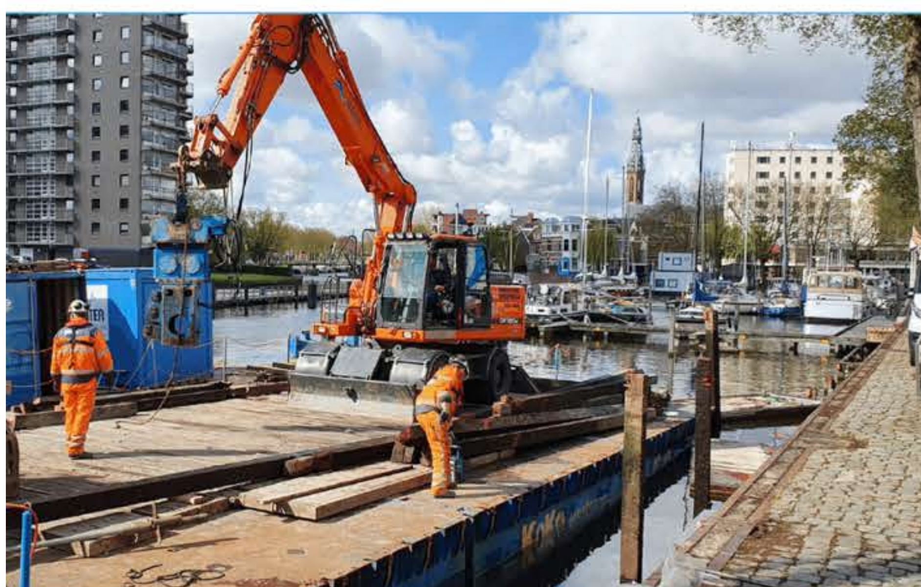
Vervangen steigers Oosterhaven
